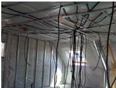
Installation d'un circuit électrique dans une maison
