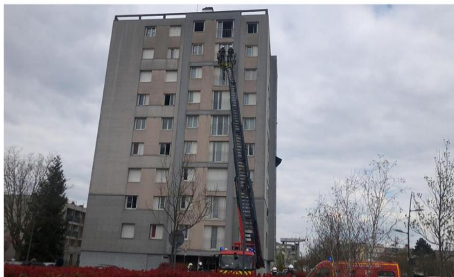
Incendie dans un appartement situé au 52 avenue Jean-Moulin à La Chapelle-Saint-Luc. Le compteur électrique pourrait en être la cause.
